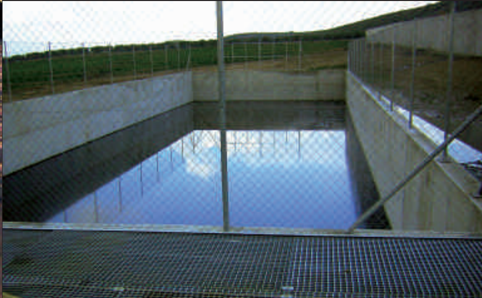
Ilustración 13.- Balsa de lixiviados
